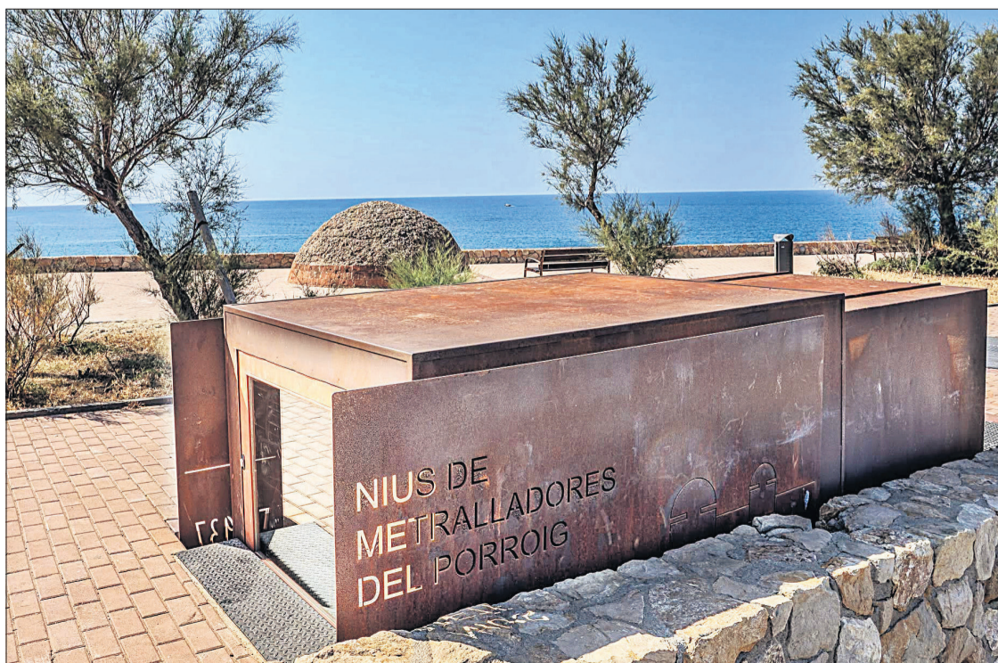
Entrada als Nius de Metralladores de la Guerra Civil al Porroig, visitables un cop al mes.
