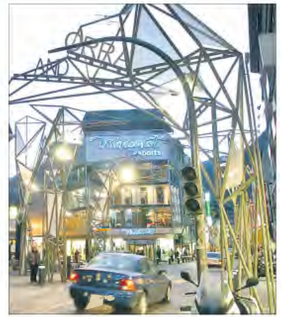
Les estructures de Meritxell.
