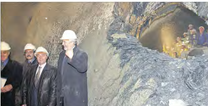
Connexió del túnel d'Envalira.
