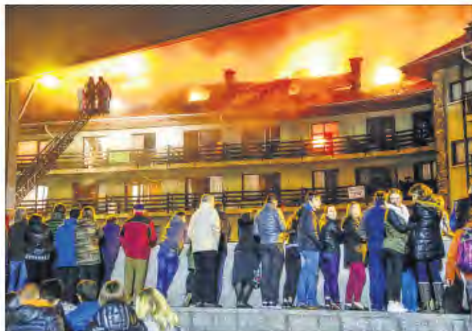
Incendi de l'edifici Tiffany's, a la Massana, el 29 de març.
