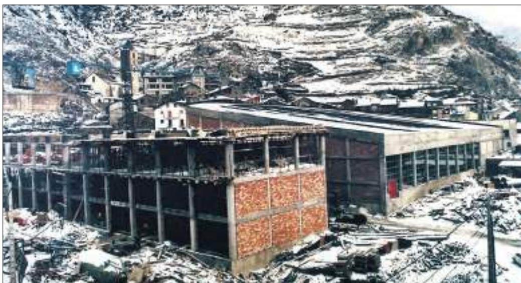
Les obres de construcció del Palau de Gel, l'any 1987.
