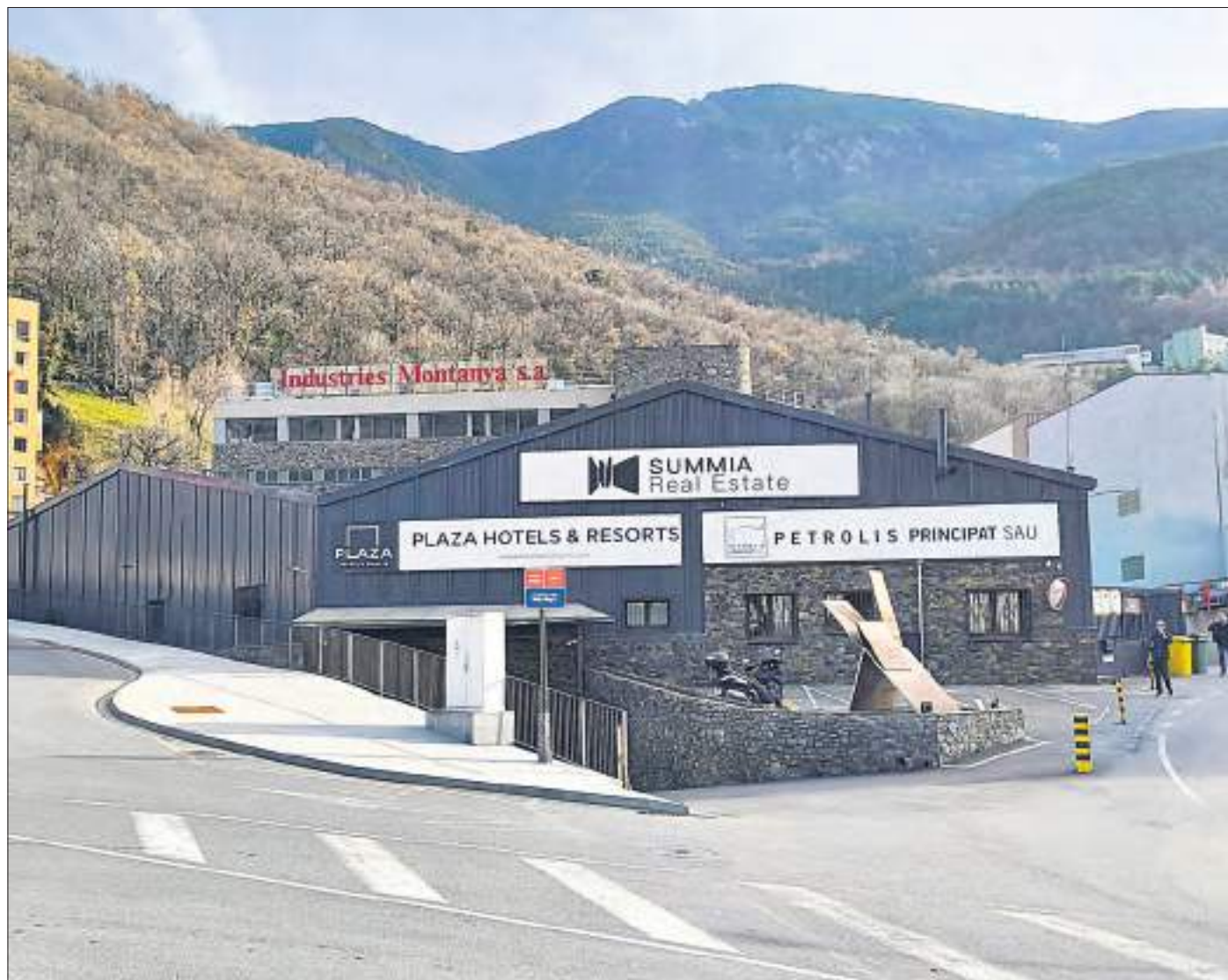
La seu social de Grup Cierco, a la carretera de la Comella.
