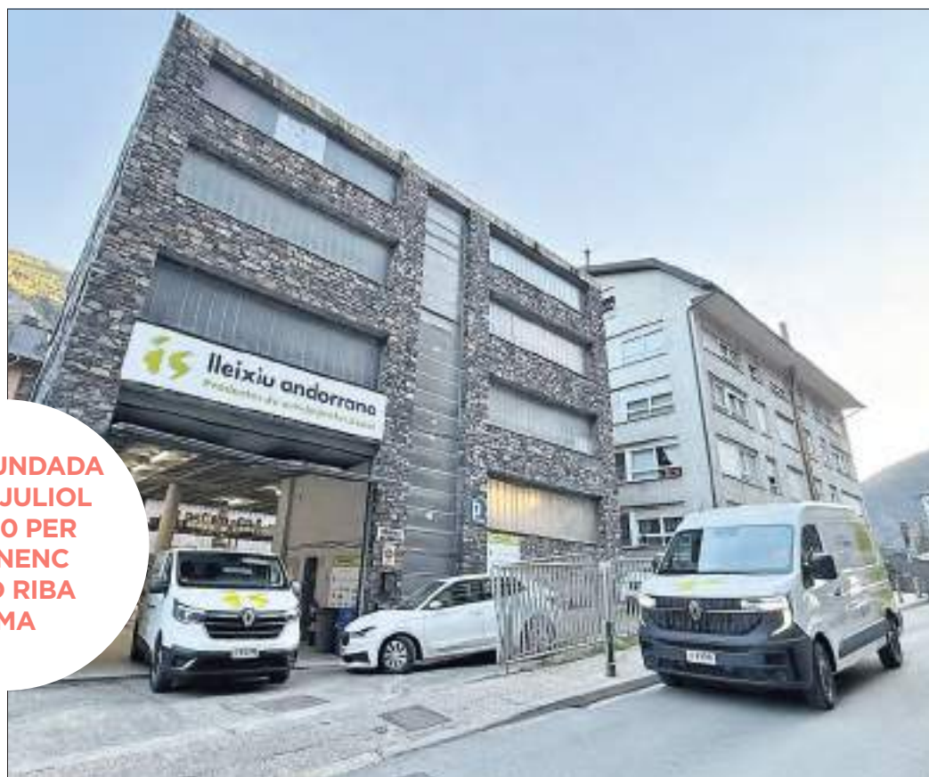
Les actuals instal·lacions de Lleixiu Andorrana.
