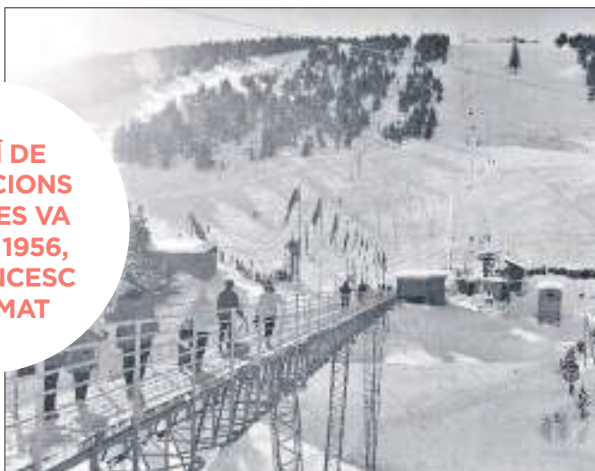
El pont del sector de Soldeu.
