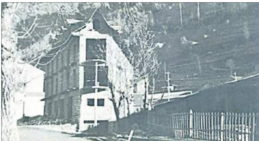
La Casa La Cruz en ple procés de construcció.
