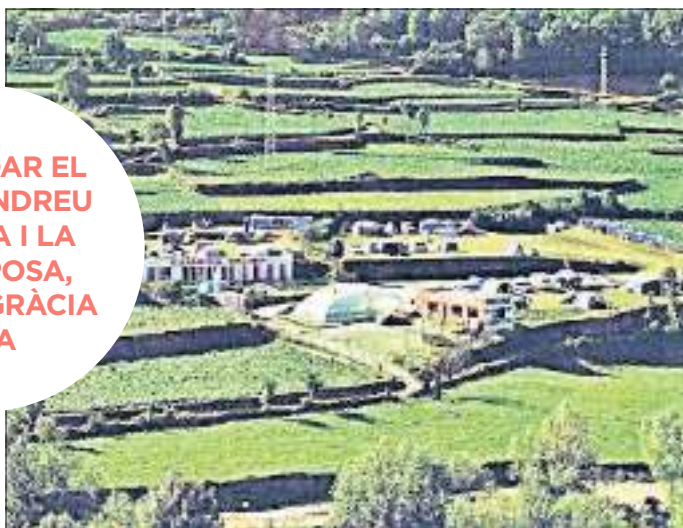
Imatge panoràmica de la instal·lació.
