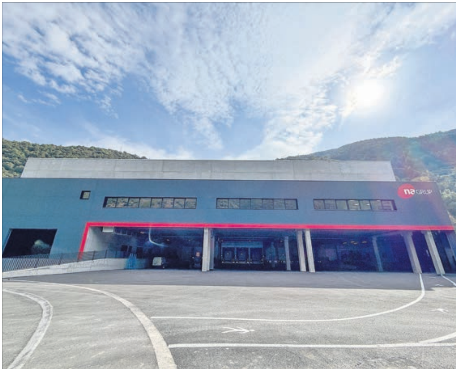
Instal·lacions del nou centre logístic de naGRUP Andorra.
