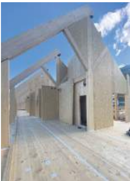
Altura Arquitectes: Edifici amb estructura modulada i prefabricada en taller.
