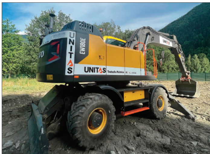
Una de les excavadores de la constructora.
